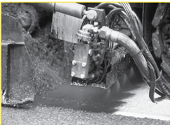
FIGURE 8 Finisseur avec rampe intégrée
