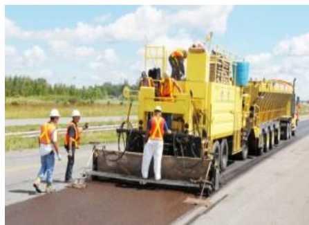
Enrobé coulé à froid
