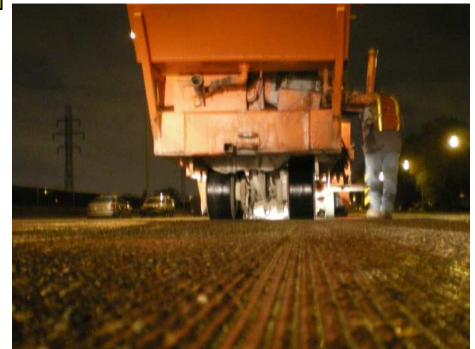
Correction par meulage
