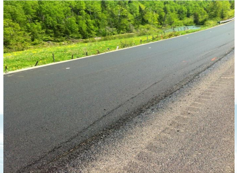
Image prise lors de visite de chantier 2012
