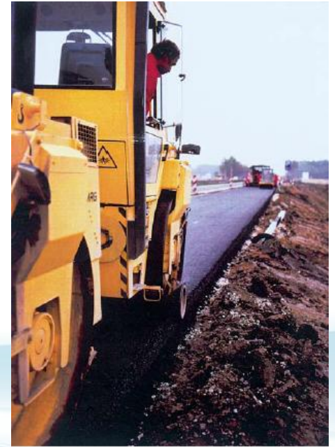
Figure 6 – Roulette latérale pour compacter le bord de la couche et éviter le fluage de l'enrobé. Une bonne visibilité est nécessaire pour la conduite du compacteur.
