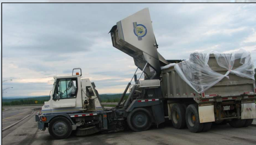
Planage – Chargement des camions
