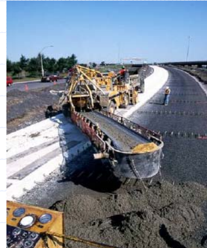
Dalle béton goujonnée
