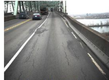
2009, Voie 1 (direction sud), 0+120
