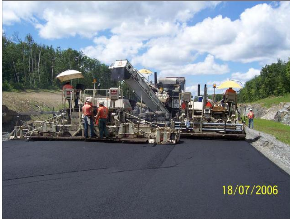
Photo 4 – VTM de type Shuttle Buggy SB-2500B alimentant 2 finisseurs pour 3 voies de largeur (contrat 5671-06-0701)
