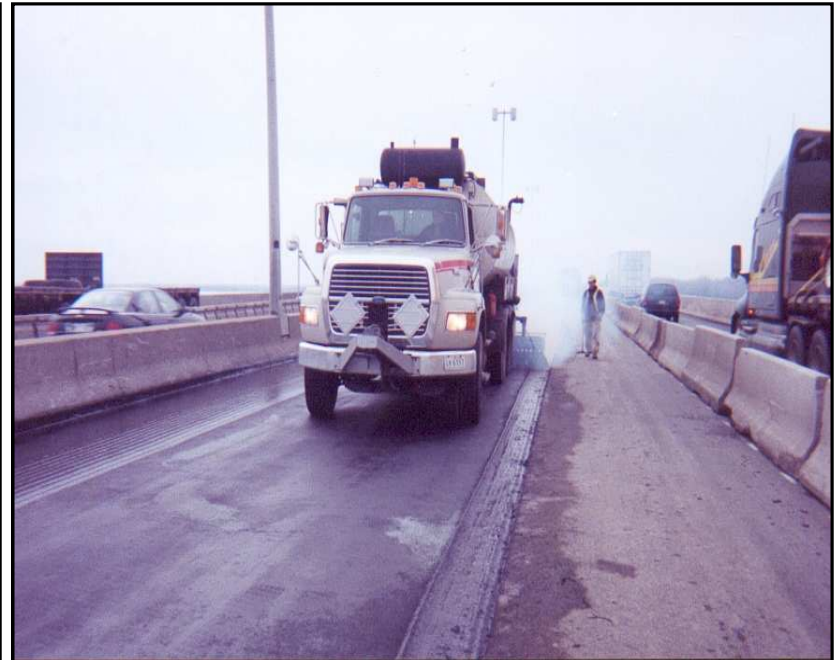
Membrane bitumineuse répandue à chaud
