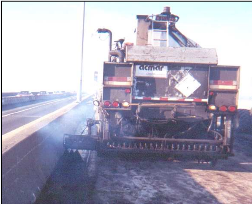
Réalisation du relevé en rive
