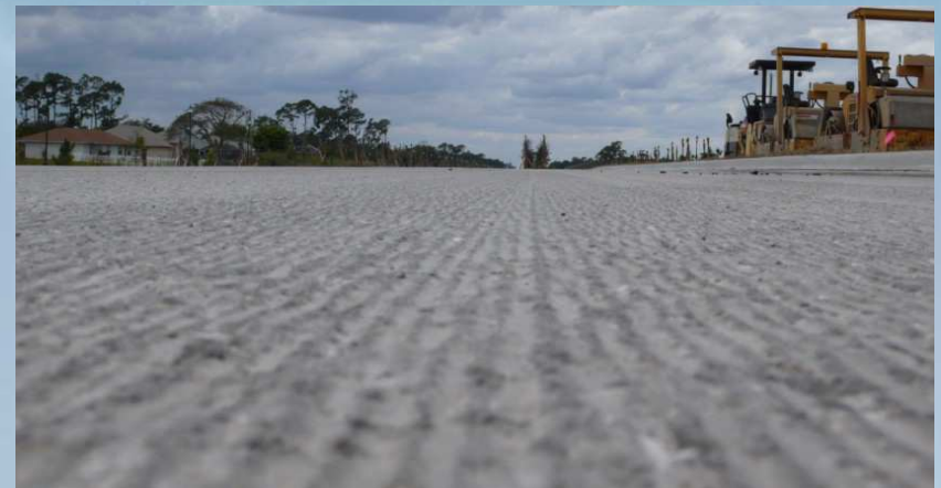
Traitement en surface
