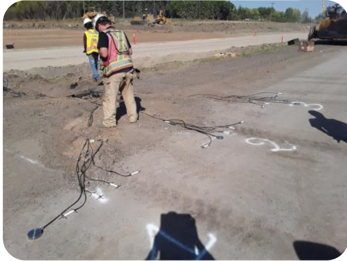
Voies de circulation
