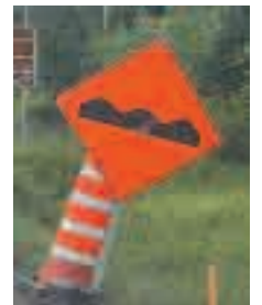
T-RV-7 utilisé en remplacement d'une barrière ← T-RV-7 utilisé pour renforcer la présence d'un panneau trop bas →
