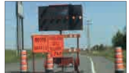
T-RV-7 utilisé en remplacement d'une barrière ← T-RV-7 utilisé pour renforcer la présence d'un panneau trop bas →
