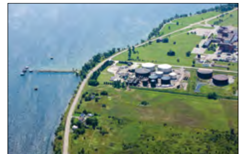
Terminal de Millhaven
