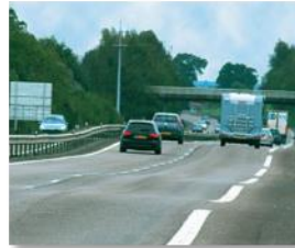
Uni- Défauts de profils
